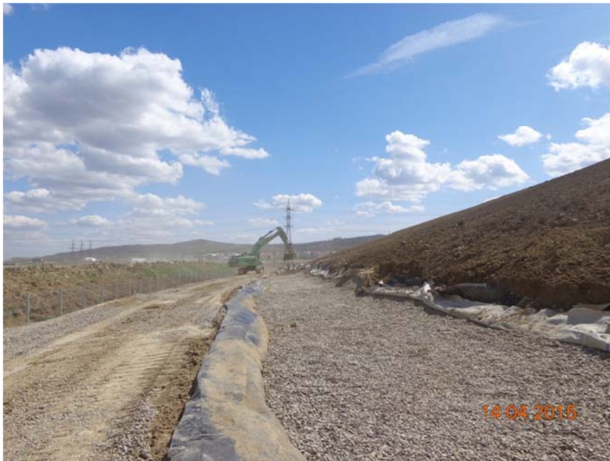
realizare straturi de inchidere la baza depozitului
