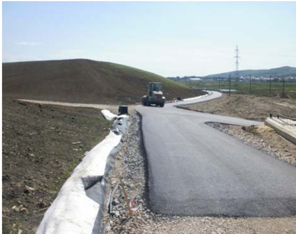
Drum asfaltat către bazinul de colectare levigat
