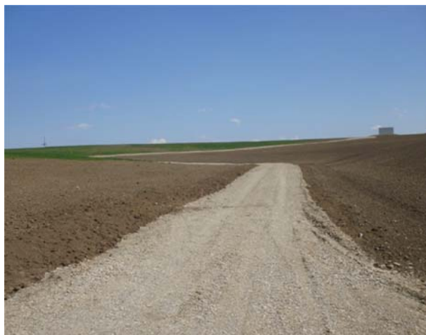
Drum pietruit pe depozit către substația biogaz
