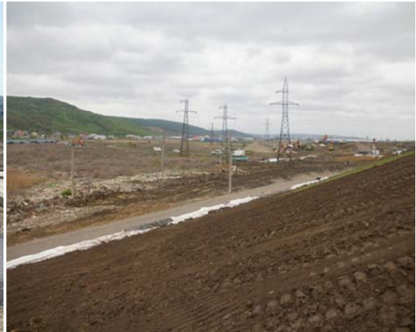
Vedere strat vegetal pe corpul depozitului închis
