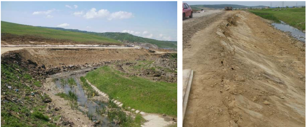
Realizarea drumului perimetral în zona albiei pârâului Vamasoia
