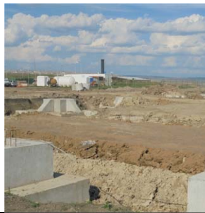
Strat pământ peste blocajul din beton - Hala Mecanica.
