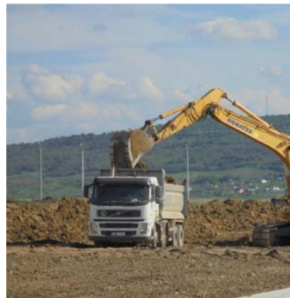
Evacuare pământ necorespunzător - Hala Biologica.
