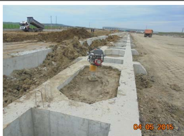
Umpluturi cu pământ între pahare și grinda de rulare și umpluturi la fundații, ax E.
