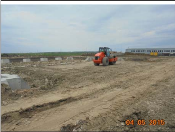
Compactare strat pământ peste blocaj- Hala Mecanica.
