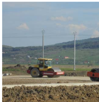
Compactare pământ - Hala Maturare.
