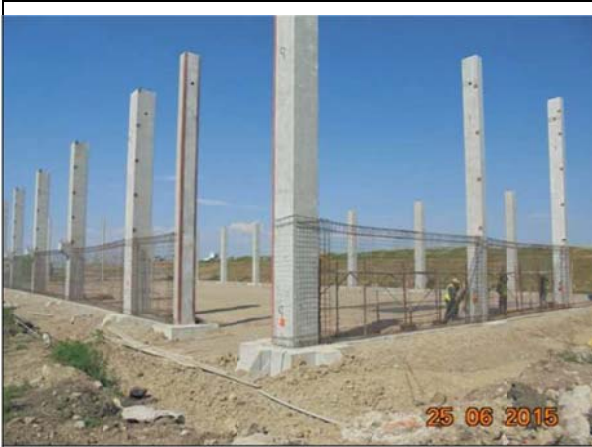
Montare stâlpi prefabricați.
