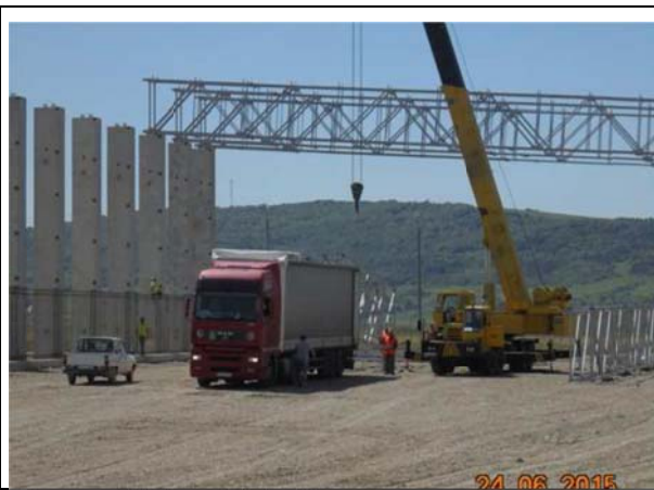
Montare stâlpi prefabricați.
