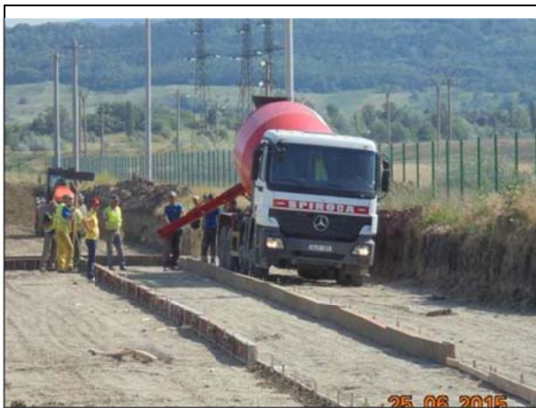
Montare stâlpi prefabricați.
