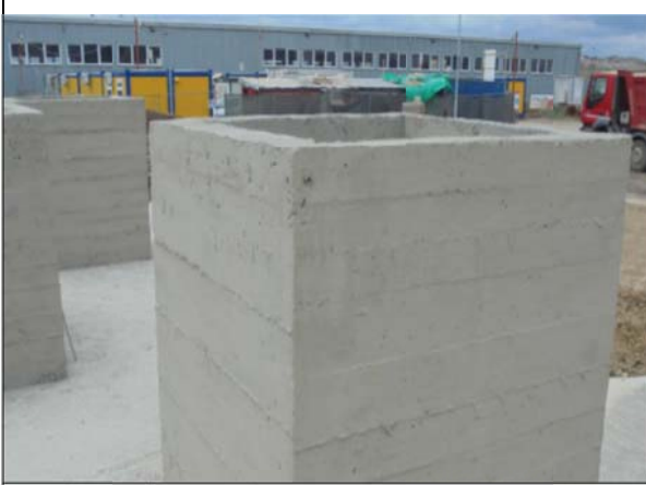
Decofrare chepenguri rezervoare.
