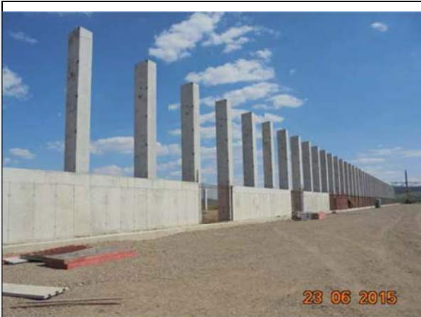
Montare stâlpi prefabricați.
