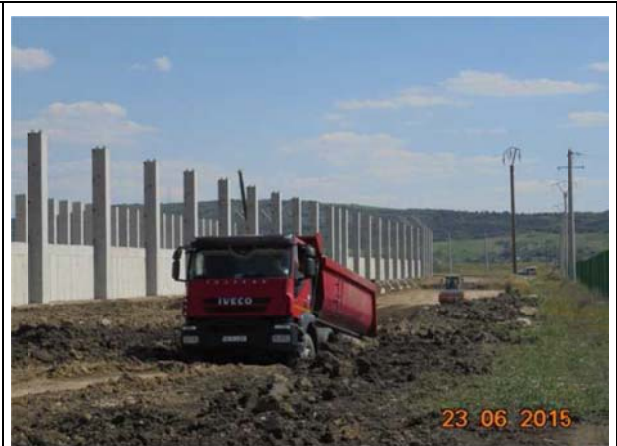
Montare stâlpi prefabricați.
