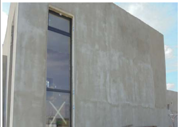
Pavilion administrativ exterior
