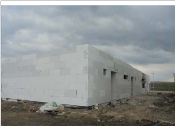
Pavilion administrativ exterior
