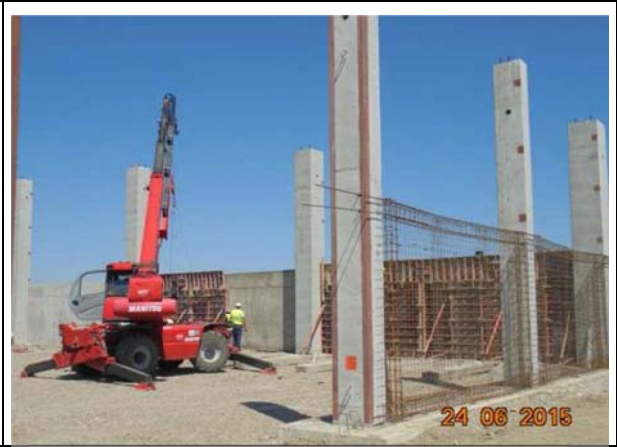
Montare stâlpi prefabricați.
