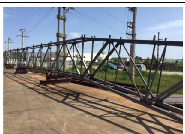
Grinzi metalice pentru acoperiș executate de către SC Orion Auto Invest SRL.
