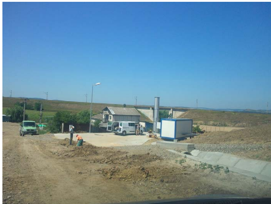
Vedere depozit inchis (detaliu la intrarea pe depozit - platforma betonata container regularizare debit biogaz si facla, podet trecere spre drum acces pe depozit (piatra sparta), rigola betonata
