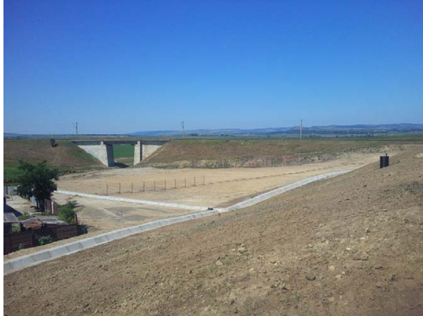
Vedere depozit inchis (detaliu cu rigola perimetrala colectare ape meteorice)
