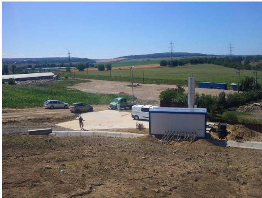
Detaliu intrare in incinta depozitului inchis, cu platforma betonata container regularizare debit biogaz si facla
