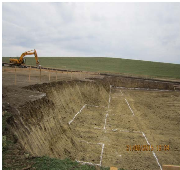
Trasare lucrări –ziduri de sprijin
