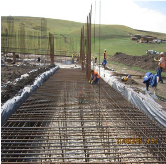
Armare radier talpa zid sprijin și elevații
