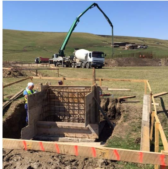
Armare și cofrare gura de vărsare
