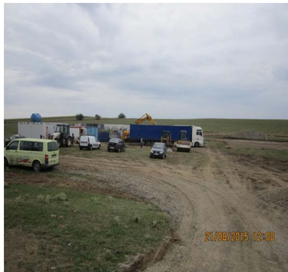
Organizare de șantier in lucru
