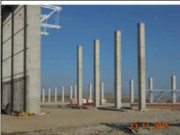
Stalpi extindere, Hala Tratare Biologica.
