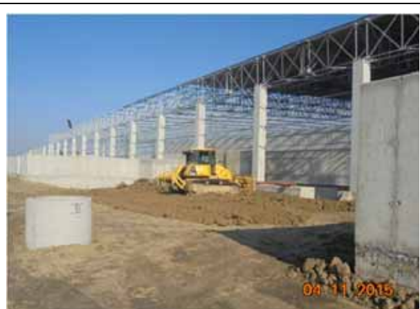
Amenajare platforma intre biofiltre.
