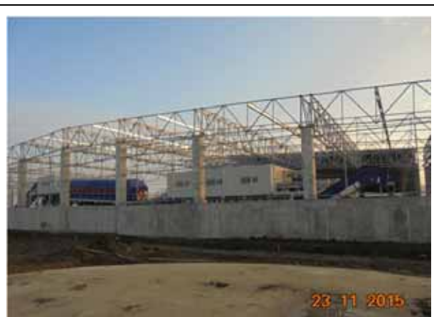
Structura metalica acoperis Hala Tratate Mecanica.
