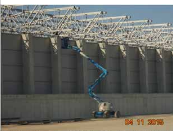
Montare structura metalica, Hala Tratate Biologica.
