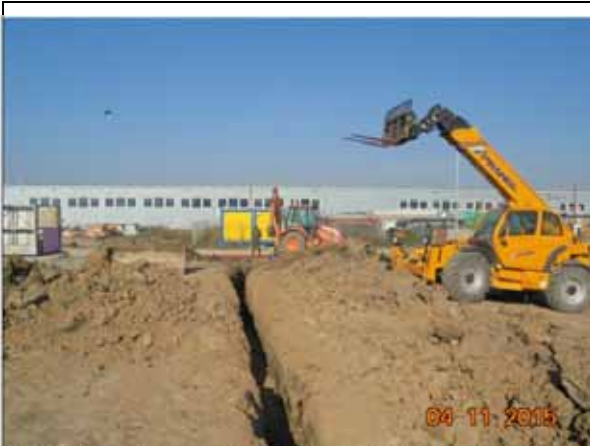
Sapat santuri pentru cabluri electrice – Rezervoare Apa.
