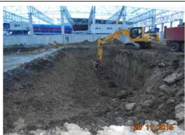
Sapatura bazin retentie levigat si ape colectate de pe platforme, Hala Tratate Biologica.
