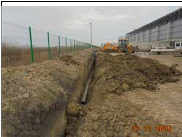
Retea apa potabila din zona Biofiltrelor.
