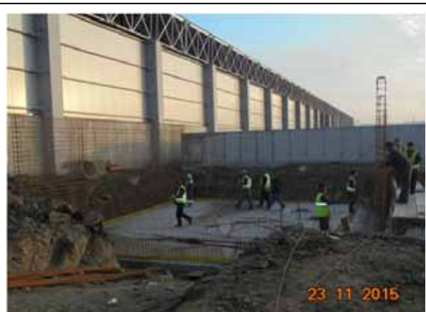
Cofrare pereti bazin retentie levigat, Hala Tratate Biologica.
