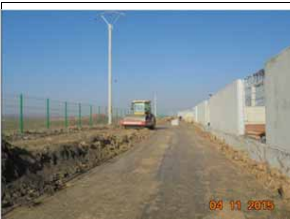
Compactat pamant drum acces de la km 0+225 pana la km 0+025, sectiunea 3.
