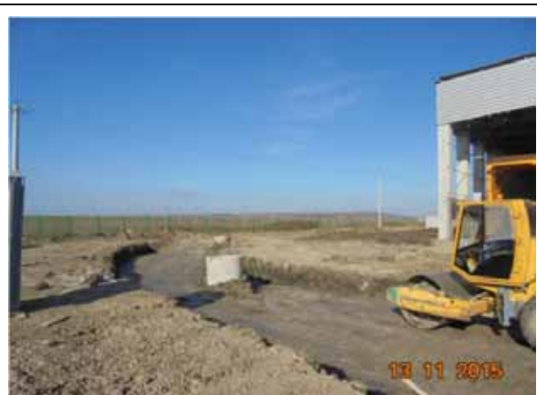
Compactare pamant drum acces de la km 0+375 pana la km 0+238,74, sectiunea 3.
