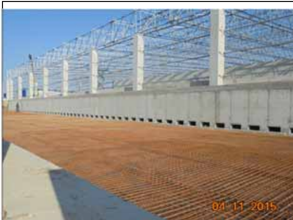
Armare pardoseala Biofiltru 2.
