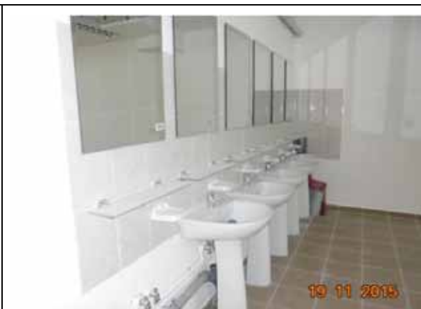
Montat obiecte sanitare.
