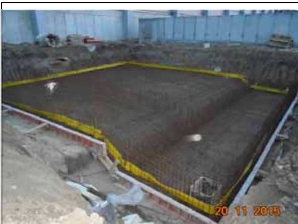
Armare radier bazin retentie levigat, Hala Tratate Biologica.
