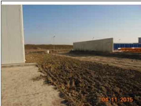
Scarificare pamant drum acces de la km 0+175 pana la km 0+261,77, sectiunea 4.
