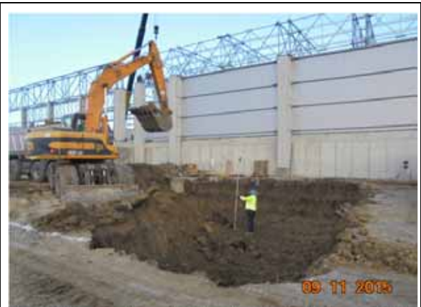
Sapatura bazin retentie levigat Hala Tratate Biologica.
