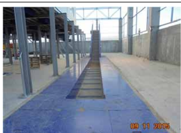
Montare echipamente Stadler, Hala Tratate Biologica.
