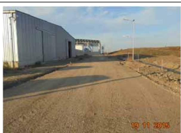
Strat balast drum acces de la km 0+175 pana la km 0+050, sectiunea 4.
