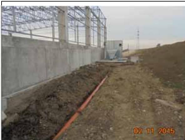
Retea canalizare Statie Sortare.
