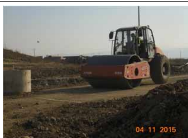
Compactare strat balast drum acces de la km 0+000 pana la km 0+175, sectiunea 4.
