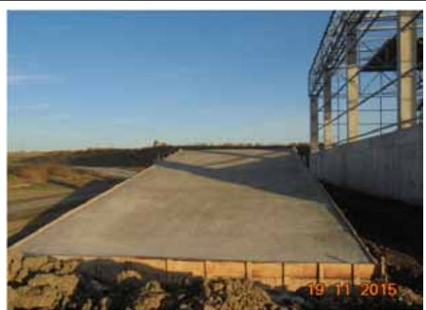
Rampa descarcare deseuri sticla.
