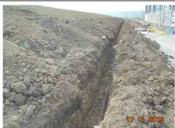
Pozare cabluri electrice.- Statia de Sortare.
