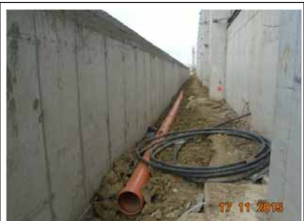
Pozare teava canalizare Biofiltre.
