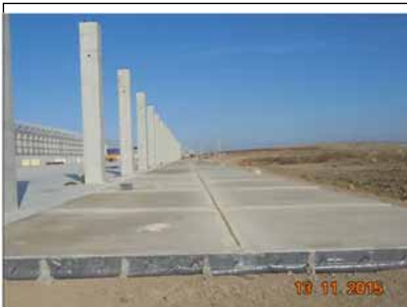
Drum acces din beton de la km 0+375 pana la km 0+500, sectiunea 3.
