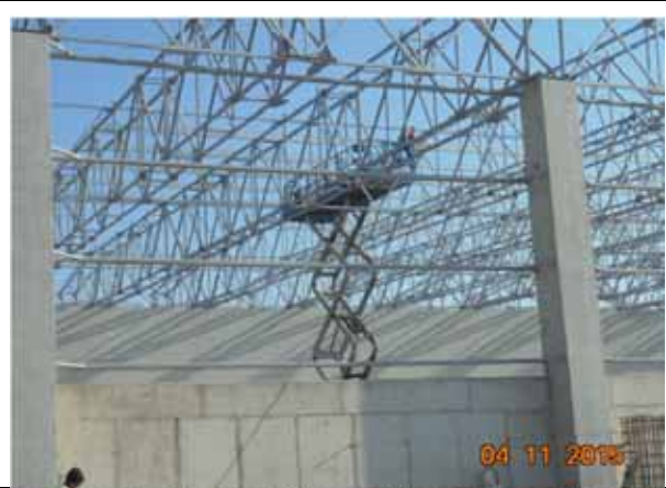
Montare structura metalica, Hala Tratate Biologica.
