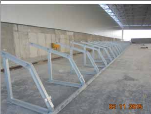
Structura metalica pentru sustinerea zidului de inox, Hala Tratate Biologica,
