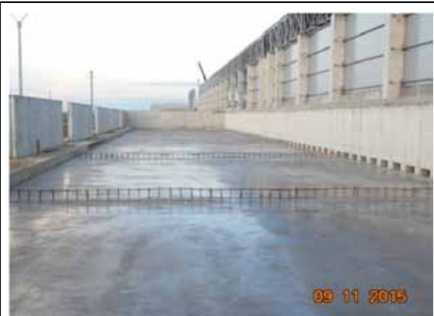
Turnare beton pardoseala Biofiltru 1.
