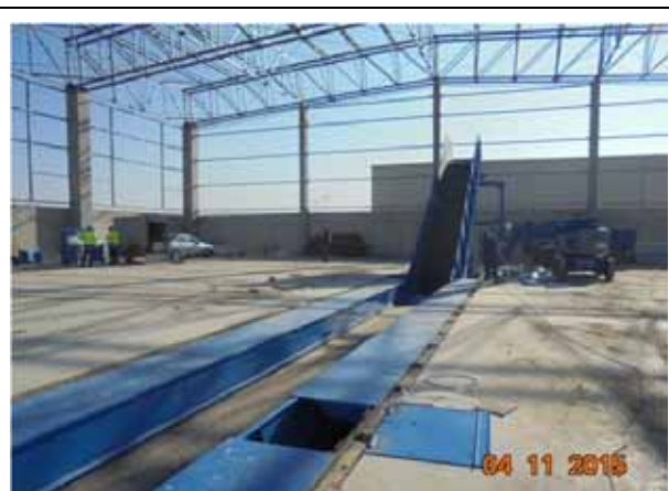
Echipamente Static Sortare.
