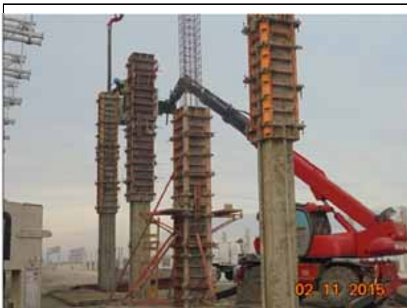
Cofrare si turnare stalpi extindere, Hala Tratare Biologica.
