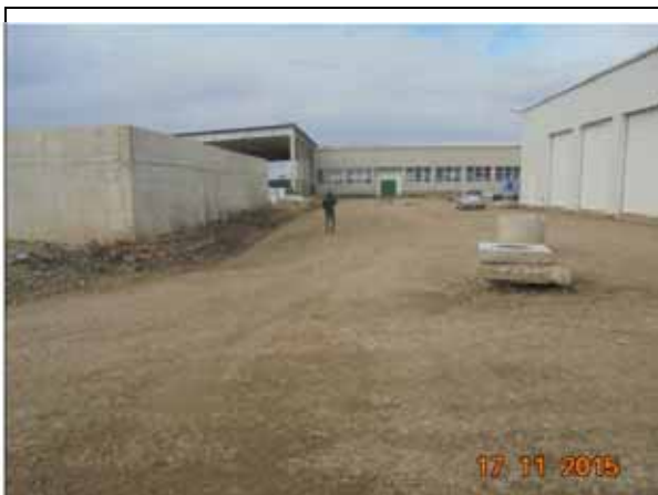
Strat balast drum acces de la km 0+175 pana la km 0+261,77, sectiunea 4.
