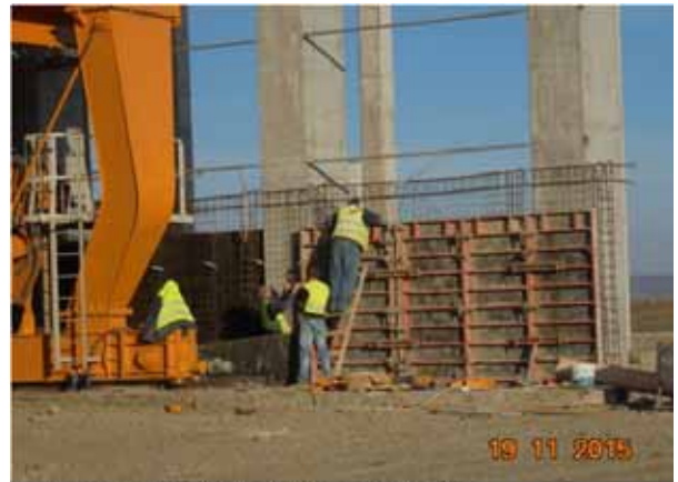
Cofrare perete Hala Tratate Biologica.
