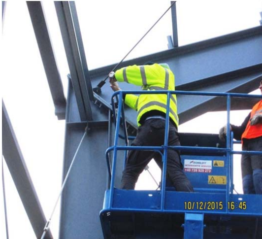
Hala Sortare - verificare imbinari grinda -stalp cu suruburi SIRP
