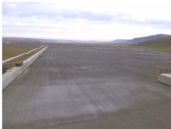
Zona de transfer
