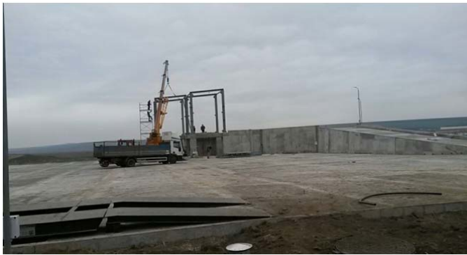
Zid de sprijin si platforma
