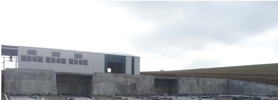
Zid de sprijin 2
