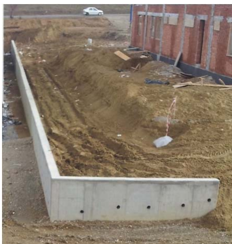
Zid de sprijin 1
