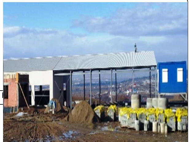
Hala Sortare - montaj acoperis din tabla cutata
