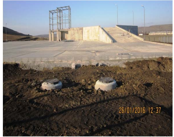
Separator hidrocarburi - lucrari de sistematizare verticala
