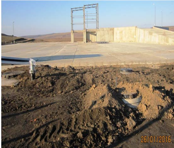
Lucrari de sistematizare – umpluturi la limita platformei
