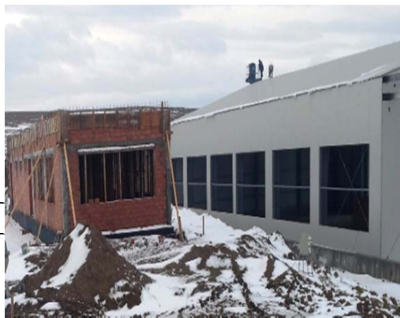
Cladirea Administrativa - decofrare centuri si grinzi planseu
