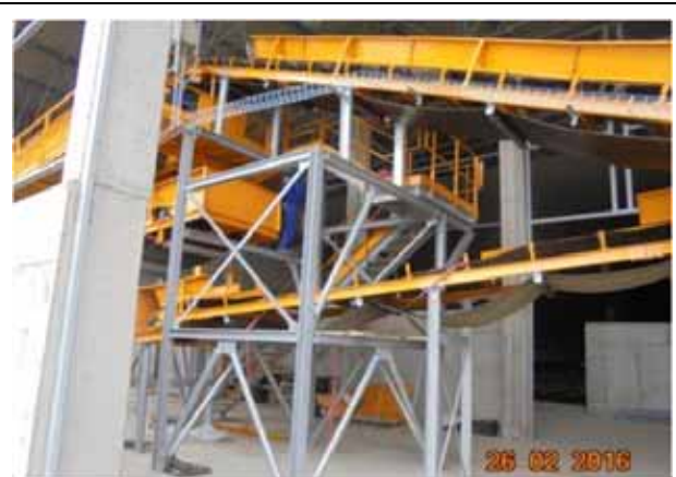
Montat pat de cabluri pentru instalatia de rafinare, Hala Tratate Biologica.
