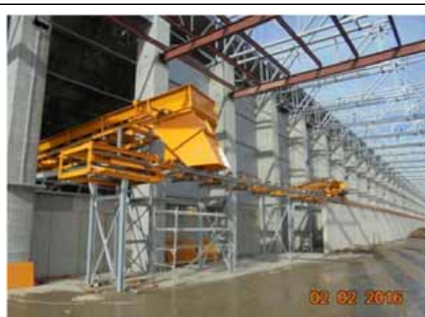
Montare echipamente S.C.T. - legatura dintre banda de descarcare, ax E, Hala Maturare si banda de descarcare, Hala Tratare Biologica.
