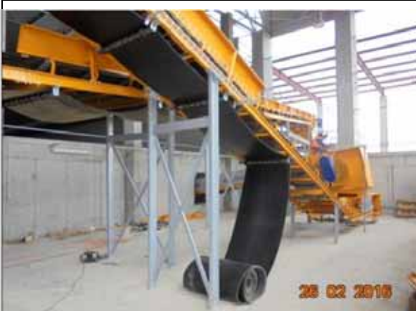
Montat banda transportoare, zona Rafinare, Hala Tratate Biologica.
