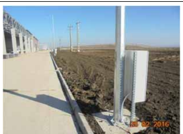
Montat tablouri electrice pentru stalpii de iluminat.
