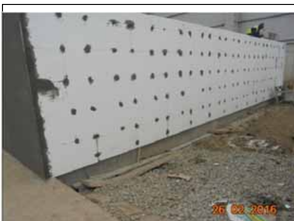
Termoizolare bazin retentie levigat.
