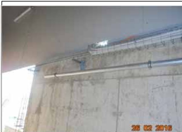
Montat pat de cabluri + cabluri electrice pentru instalatia dintre Biofiltre.
