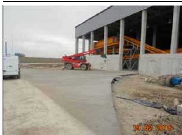
Beton rutier BcR4 turnat la zona de acces Rafinare.
