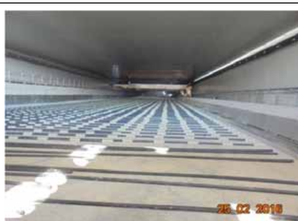
Ancorare tuburi ventilatie, Hala Tratate Biologica.
