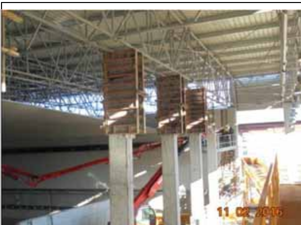
Cofrare stalpi Hala Tratate Biologica, ax 25' de la cota +7,00 m.
