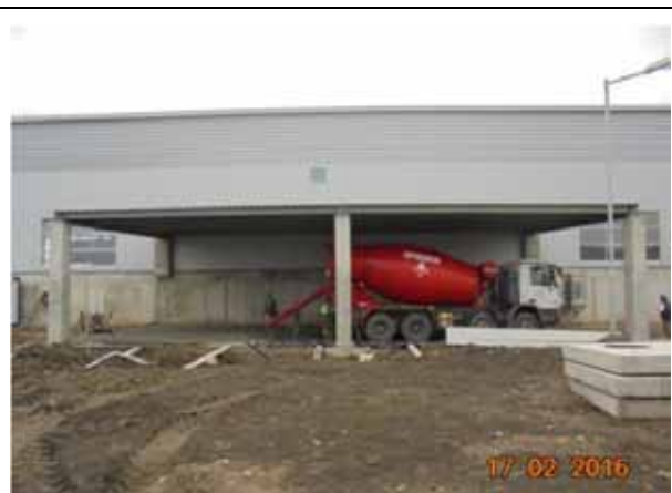
Turnare beton platformă Şopron.
