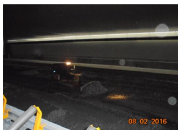
Asternere piatra sparta peste tuburile de ventilatie negativa – stratul poros, Hala Tratate Biologica.
