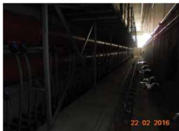
Montat tubulatura flexibila in spatele reactorului, Hala Tratate Biologica.
