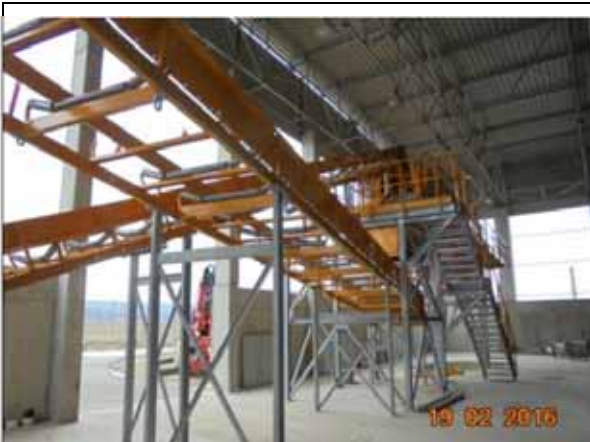
Montat utilaje, zona Rafinare, Hala Tratate Biologica
