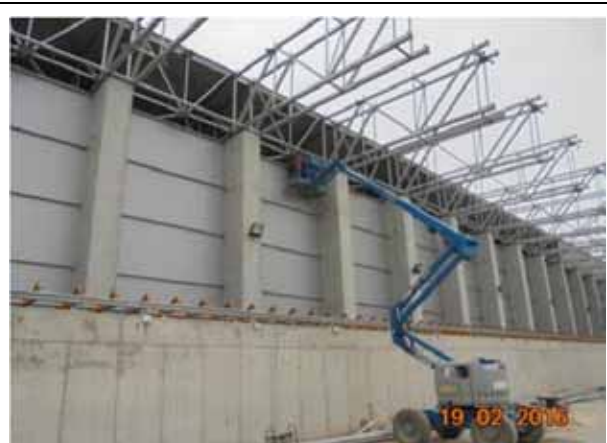
Turnat monolitizari aparat de reazem structura metalica, Hala Maturare, ax E.
