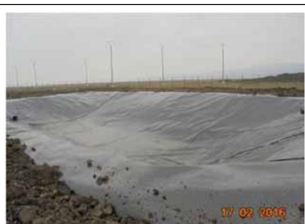
Montare geomembrana PEHD bazin 2 de retentie ape colectate de pe acoperis.
