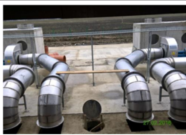
Tublatură ventilatie negativă și ventilatoare - montate.
