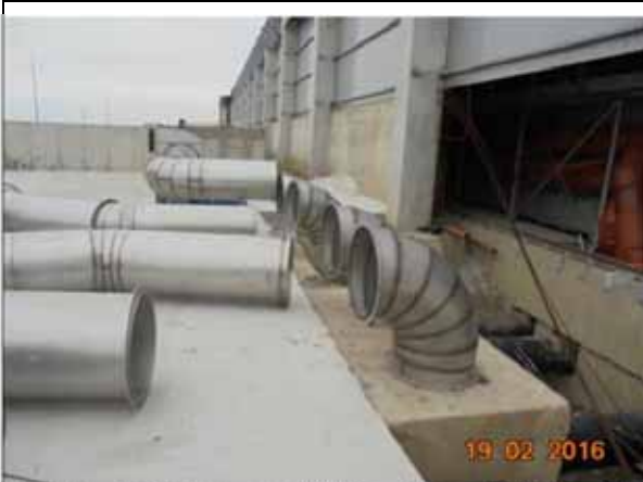
Montat tublatura ventilatie între biofiltre, Hala Tratate Biologica.
