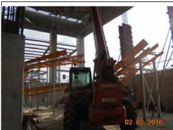
Cofrare stalpi Hala Tratare Biologica, ax 27.
