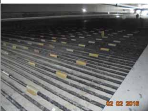
Ancorare tuburi ventilatie negativă, Hala Tratate Biologica.
