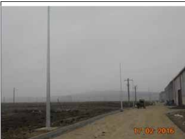
Montat stalpi de iluminat exteriori.
