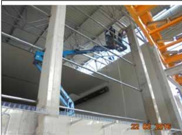
Montat rigle pentru panouri de inchidere, Hala Tratate Biologica, ax 25.
