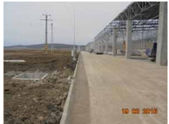
Turnat rigola, drum Sectiunea 3.
