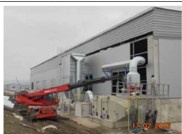
Montare structură de susținere pentru tubulatura de desprăfuire, Hala Sortare.
