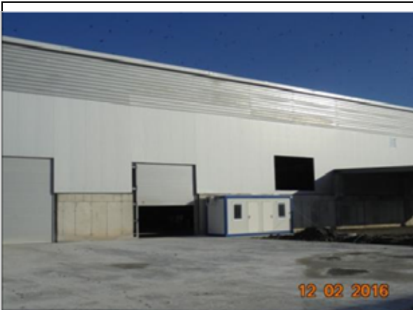
Montare container personal, Statie Sortare.
