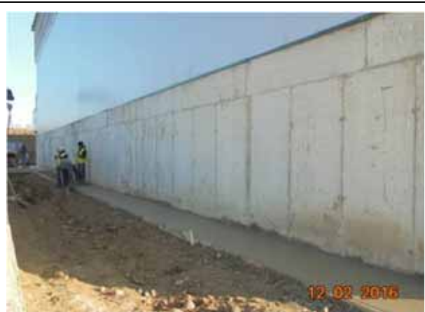
Cofrare si turnare trotuar, Statie Sortare.
