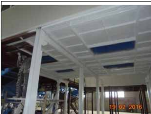
Vopsit structura metalica a cabinelor de sortare, Hala Sortare.
