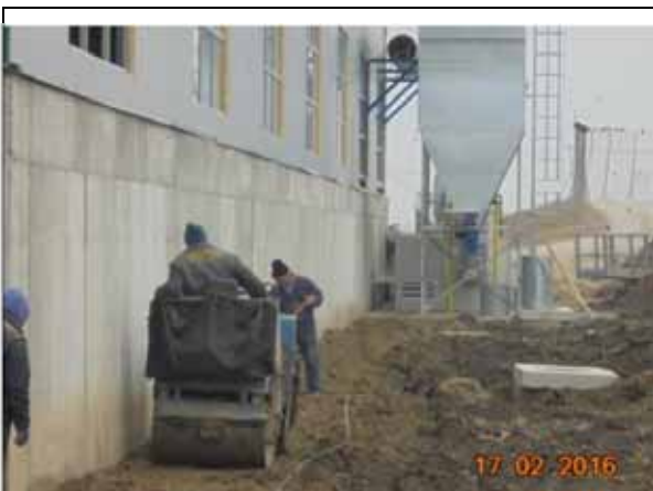
Asternere si compactare strat balast pentru trotuar, acces Hala Sortare.
