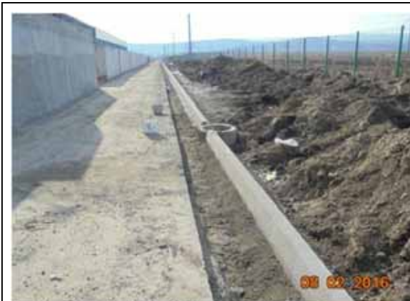
Montare borduri rigolă drum Sectiunea 3.
