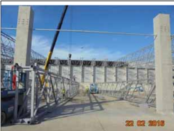
Montat grinda transversala GT3B, hala Maturare.
