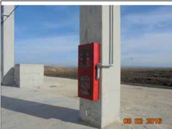
Montare cutii hidranti interiori, Hala Maturare.
