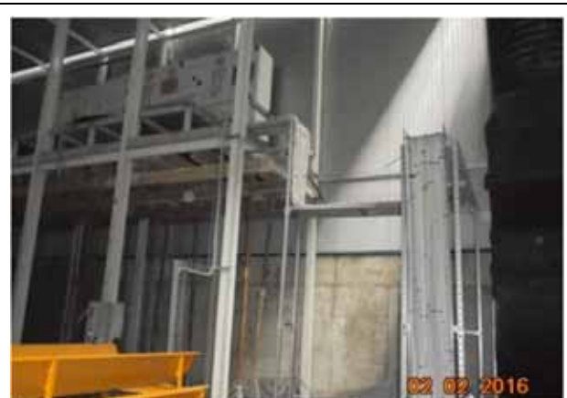
Montat instalatia electrica pentru podul rulant si camera de control, Hala Tratate Biologica.
