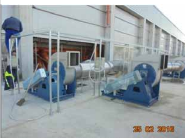
Montat pat de cabluri pentru instalatia dintre Biofiltre.
