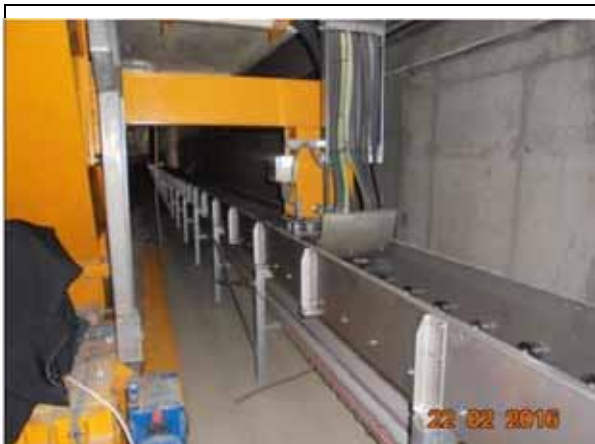
Montare paturi de cabluri mobile pentru utilajele Biomax.
