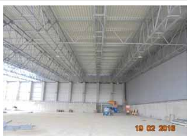
Montat tabla acoperis, Hala Maturare.
