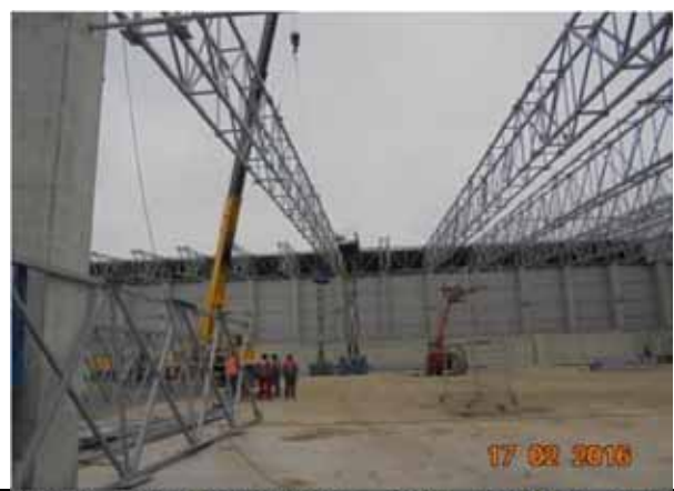
Montat grinzi transversale GT2B si GT3B, Hala Maturare.
