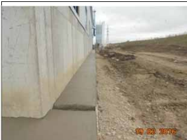
Turnare trotuar, Hala Sortare.
