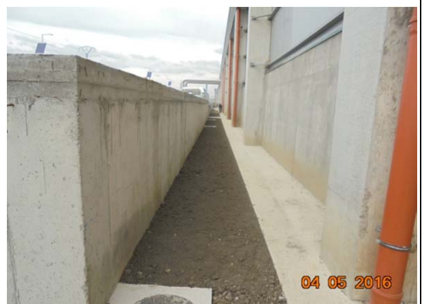
Umplutura pamant in spatele Biofiltrelor
