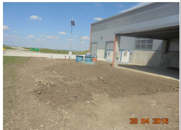
Montat Camin de pompare CP1
