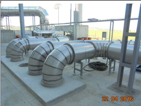
Montat tubulatura ventilatie intre Biofiltre
