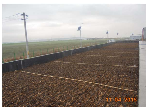
Montaj sistem de umidificare biomasa, Biofiltru 1 si 2
