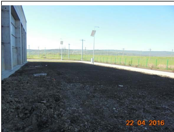
Umpluturi pamant in vederea inierbarii , drum sectiunea 3, km 0+200 – km 0+238
