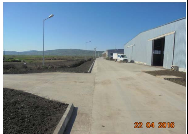
Umpluturi pamant in vederea inierbarii, drum sectiunea 4
