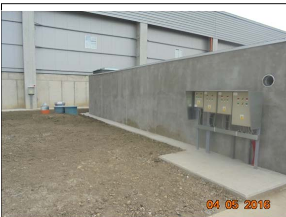
Montat Camin de pompare CP2
