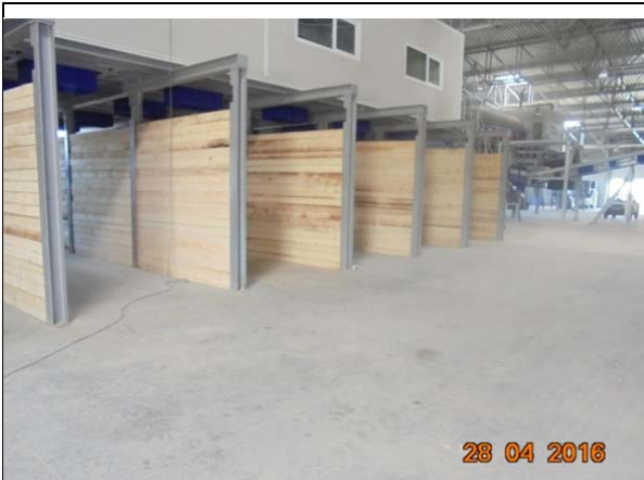
Montat rigle de lemn pentru peretii silozurilor de sortare, Hala Tratare Mecanica
