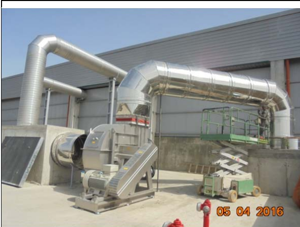
Montat tubulatura ventilatie intre Biofiltre
