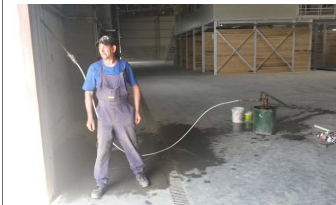
Proba presiune instalații hidranți
