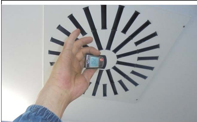
Măsurare flux aer instalații ventilație Pavilion Administrativ
