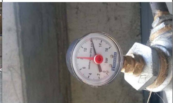
Verificare presiune instalații hidranți
