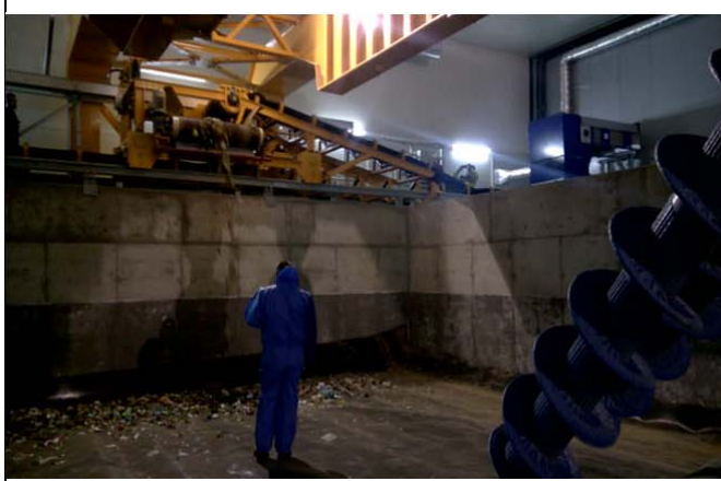
Funcționare tripper cu deșeuri , încărcare cu deșeuri a reactorului peste geomembrana provizorie
